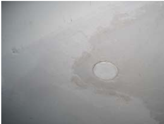
Udførelse af såkaldt concealed sprinkler placeret i loft.
