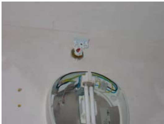
Den færdige trappe med sprinkleren monteret over lampen mellem entrédørene. Sprinkleren er så lille, at den knap er synlig.
